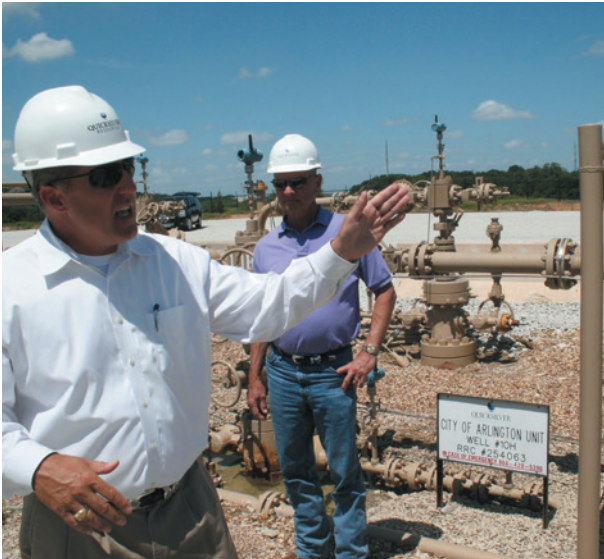
米テキサス州フォートワースのシェールガスの井戸
