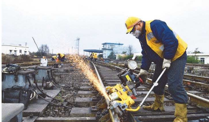
2月、四川省の貨物列車編成ターミナルで輸送力強化に向けた工事を行う作業員（中国新聞社）
