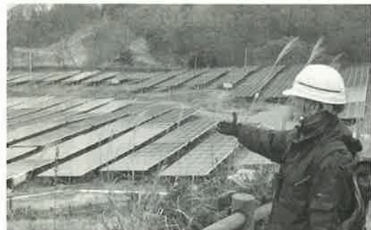
ゴルフ場跡地を活用した太陽光発電所に並ぶ太陽光パネル=福島県須賀川市(本文とは関係ありません)
