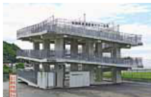
【津波避難タワー】
