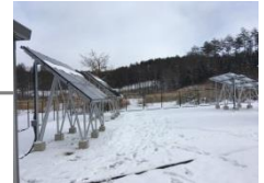
市内太陽光発電技術実証実験場 (蓄電融雪技術)
