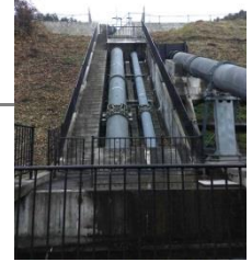
市内水力発電施設 (町川発電所: 最大出力140kw)
