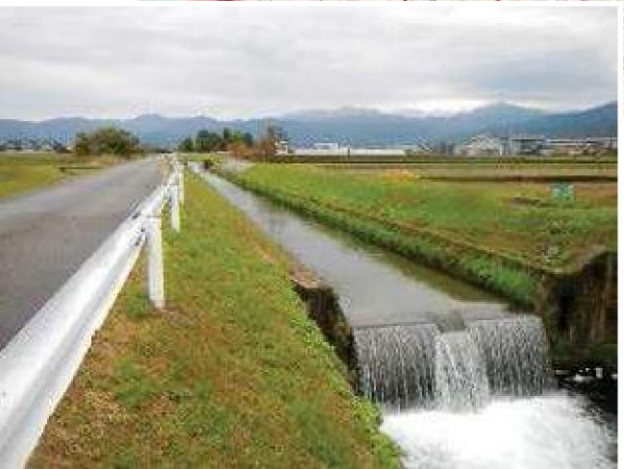
上記3点の写真はいずれも高橋川の落差であり、いずれも、6万kWh/年の発電が可能
