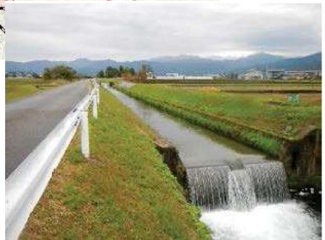
上記3点の写真はいずれも高橋川の落差であり、いずれも、6万kWh/年の発電が可能
