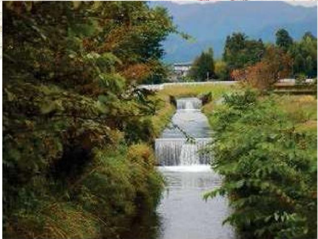
上記3点の写真はいずれも高橋川の落差であり、いずれも、6万kWh/年の発電が可能
