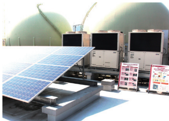
非常時に発電を担うガス空調設備と太陽光発電設備の新エネルギーシステム
