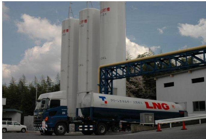
【LNG受入施設全景と13.5tタンクローリー】
